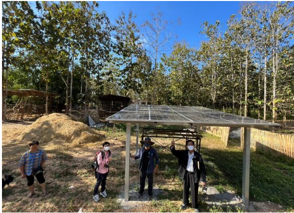
ระบบชลประทานพลังงานแสงอาทิตย์ที่บ้านหนองห้า (หมู่ที่ 8)
