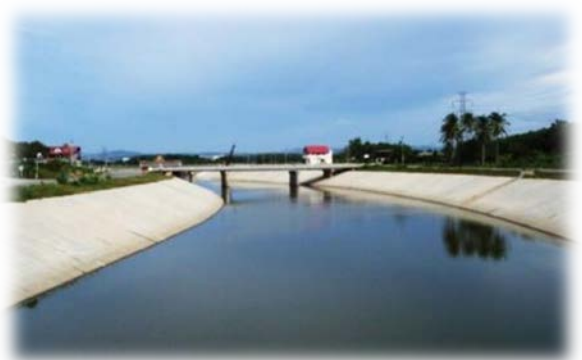
คลองระบายน้ำ ร.๑
