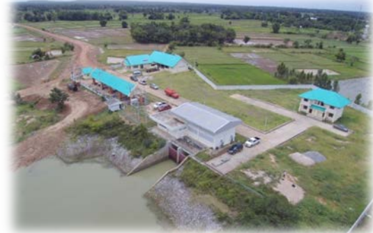
อาคารโรงสูบน้ำและบ้านพัก
