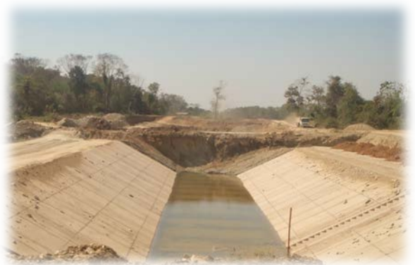
ก่อสร้างระบบส่งน้ำสายใหญ่ฝั่งขวาพร้อมอาคารประกอบ ส่วนที่ ๑
