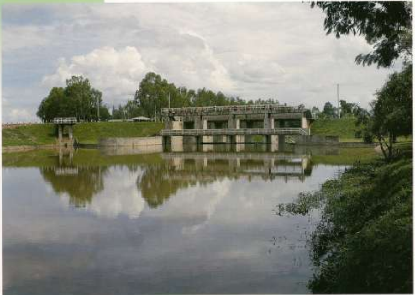
เขื่อนระบายน้ำลำน้ำเขิน อำเภอชุมแพ จังหวัดขอนแก่น
