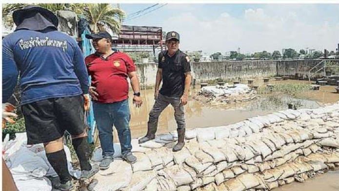
นายสิริชัย ขมเกิด ผบ.เรือนจำจังหวัดนนทบุรีร่วมกับ เทศบาลบางศรีเมือง และ อ.เมืองนนทบุรี นำ จันท.และผู้ต้องขัง วางกระสอบทรายป้องกันน้ำท่วม.
